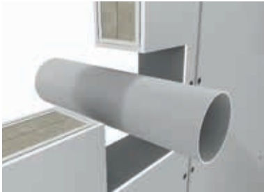
Rohbauöffnung reinigen
